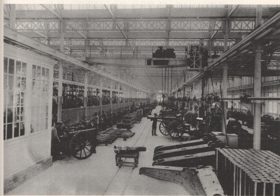
L'atelier de montage des canons de 75 avant 1914.
