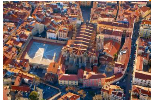
Maison de la catalanité
