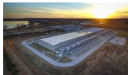
Data center Google © Wikimedia Commons
