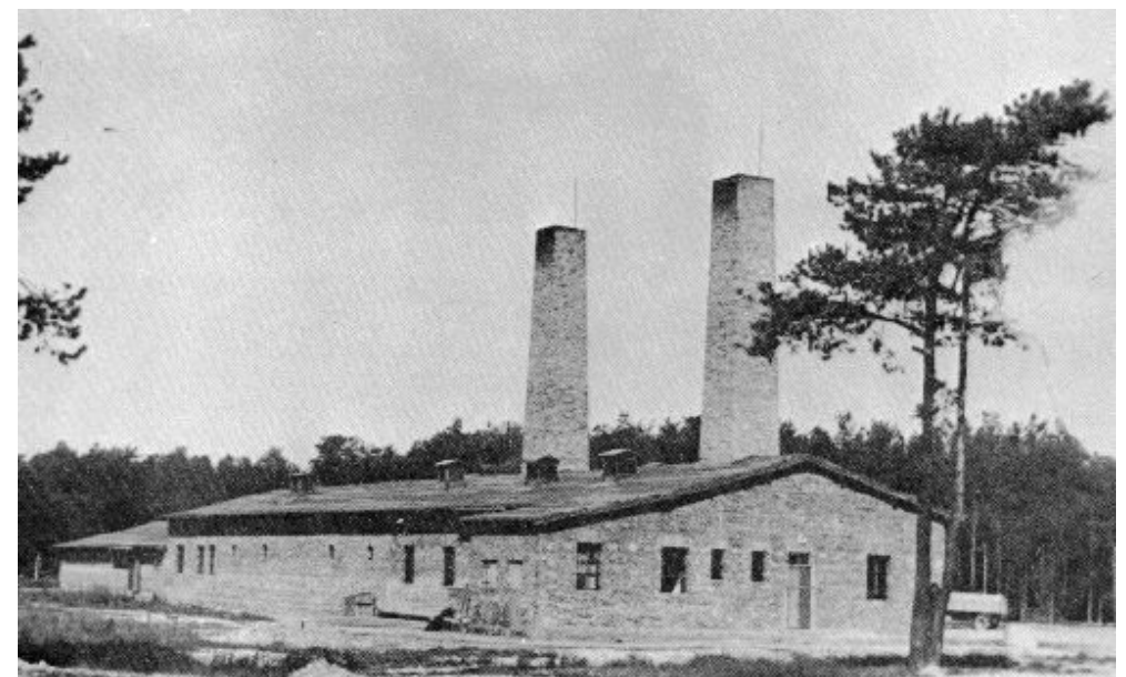
Vue générale du Krematorium IV à Auschwitz II. Les chambres à gaz sont à l'arrière. A l'avant se trouvent la morgue et le crématorium. (Source : Album Bauleitung , composé de 500 clichés pris par les SS de travaux de construction)
