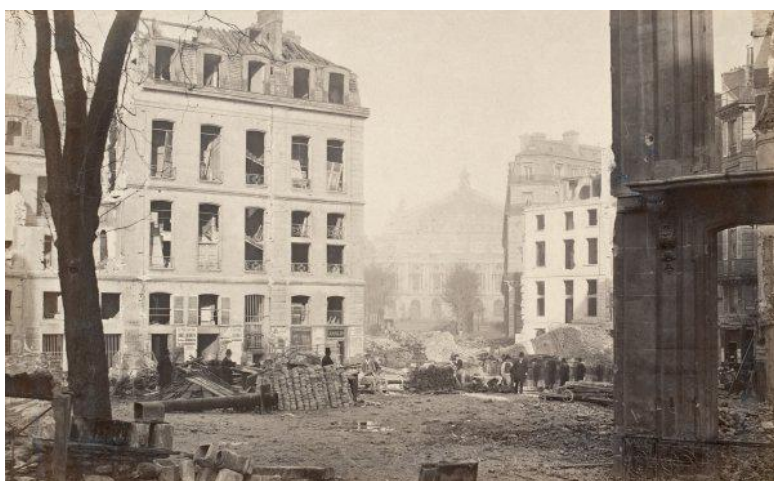
Le Boulevard de l'Opéra en travaux
