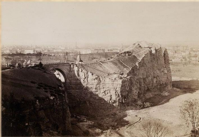
Charles Marville, aménagement du Parc des Buttes- Chaumont
