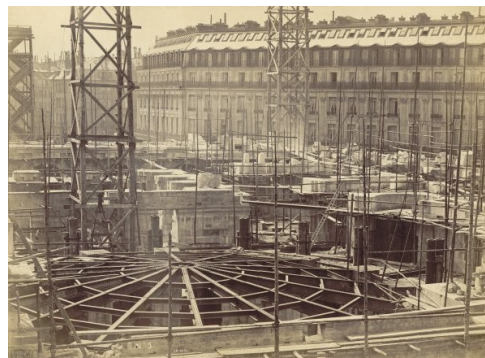
Le chantier de l'Opéra en 1864 (photographie de Charles Marville)
